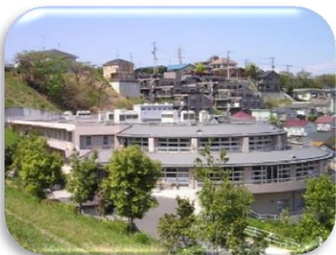
【ヒューマンケア横浜】 介護老人保健施設
