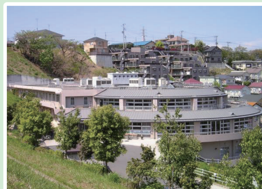
〔横浜市戸塚区〕 ヒューマンライフケア横浜 (介護老人保健施設)
